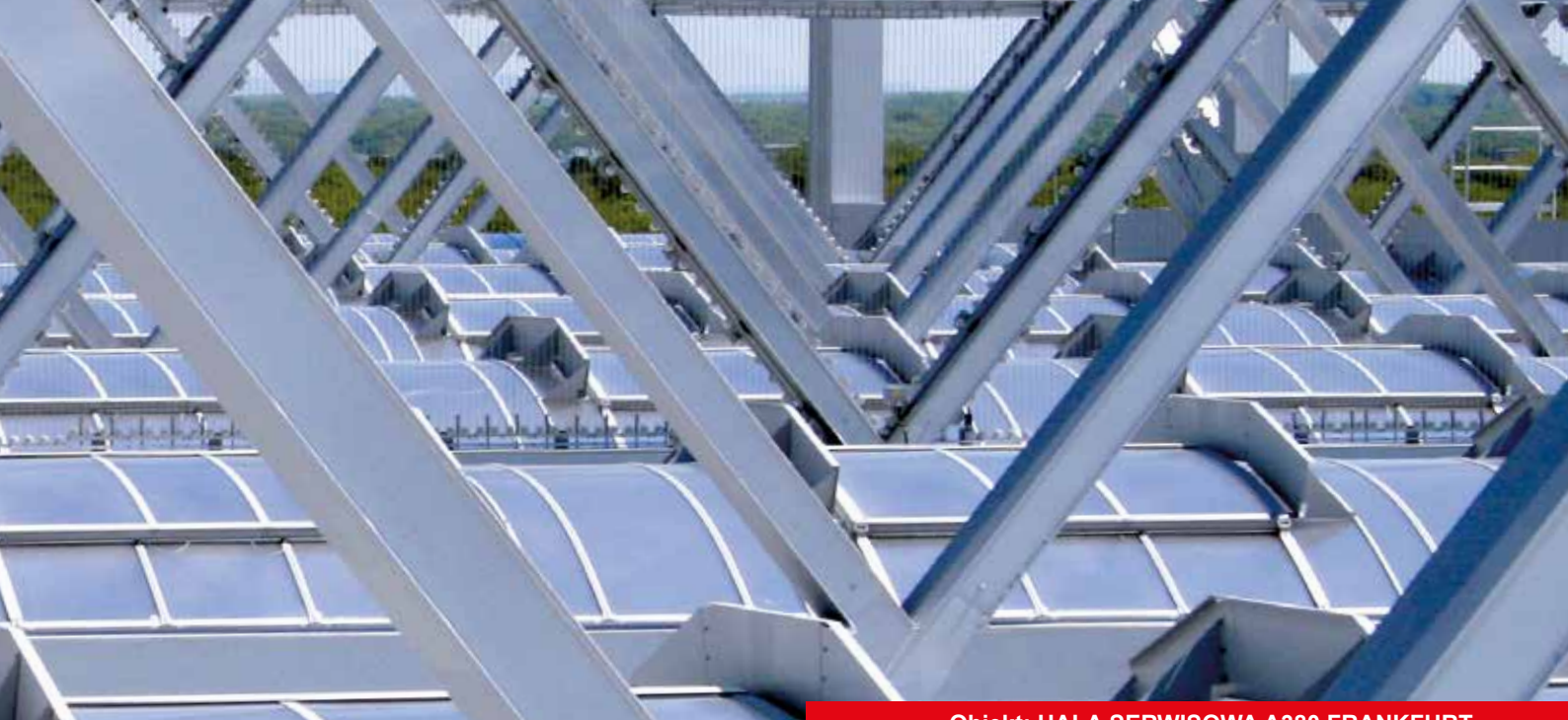
Obiekt: HALA SERWISOWA A380 FRANKFURT
