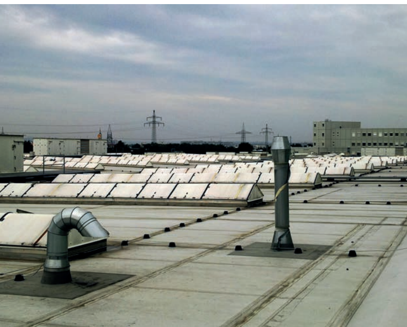
Obiekt renowacji: Schneider Electric, Regensburg
