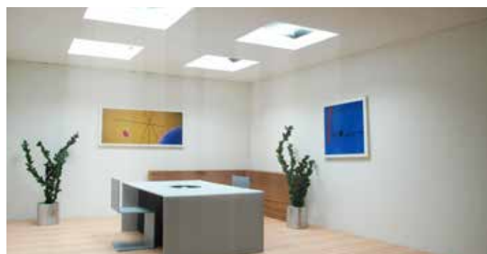
Kanał o dużych właściwościach odbijania światła – maksymalny TQ na poziomie użytkowym ok. 8%
