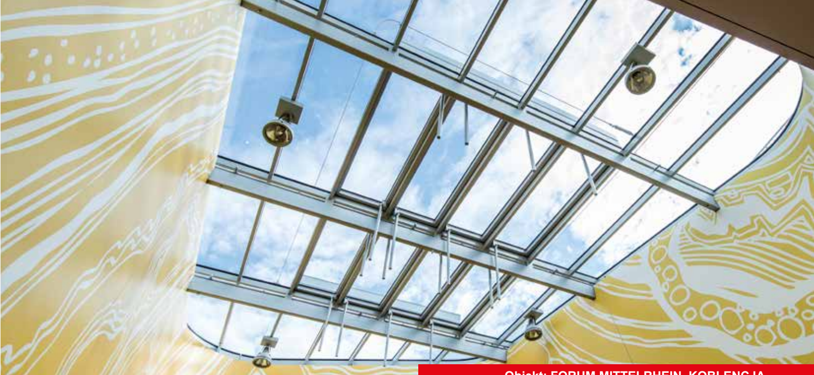
Obiekt: FORUM MITTEL RheIN, KOBLENcJA
