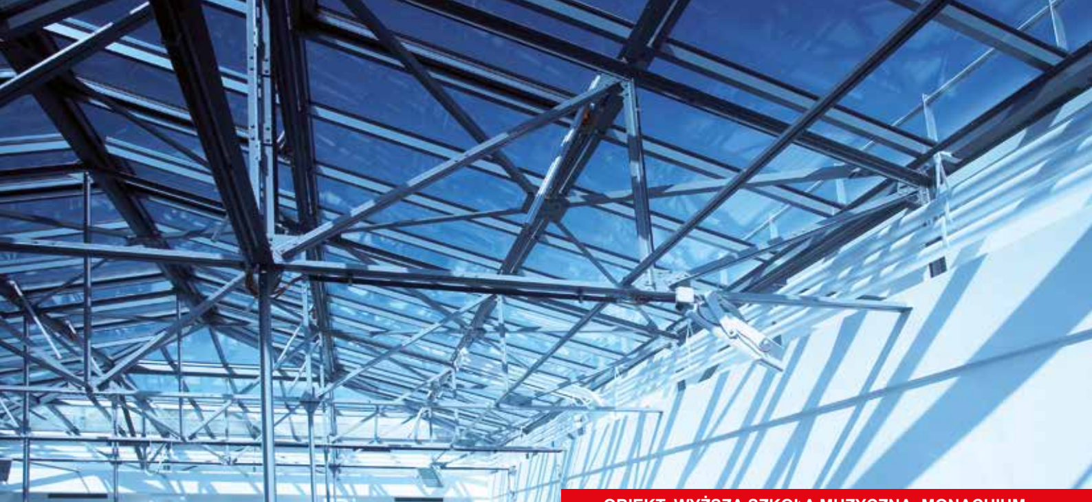
OBIEKT: WYŻSZA SZKOŁA MUZYCZNA, MONACHIUM
